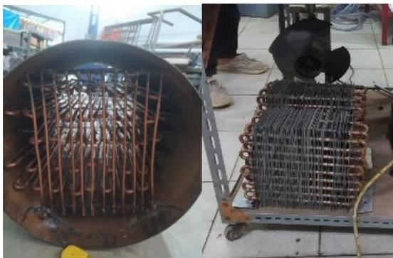
Gambar 2 *Indoor* Evaporator dan kondenser (kiri) dan *Outdoor* Evaporator dan kondenser
