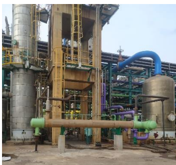
Gambar 3. New 203-C telah terpasang
