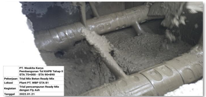
Gambar 3.3 Penambahan Fly Ash Secara Manual Kedalam Campuran Beton Ready Mix
