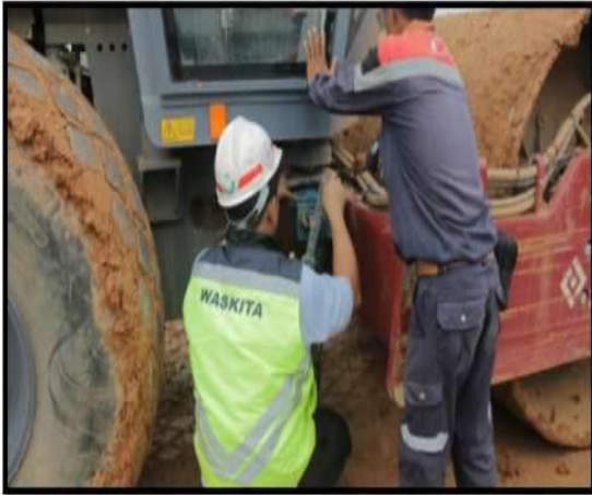
Gambar 5 Pengujian CBR landasan Crane
