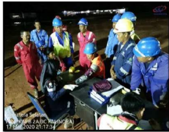
Gambar 14 Pengecekan Kesehatan Pekerja Lifting Girder
