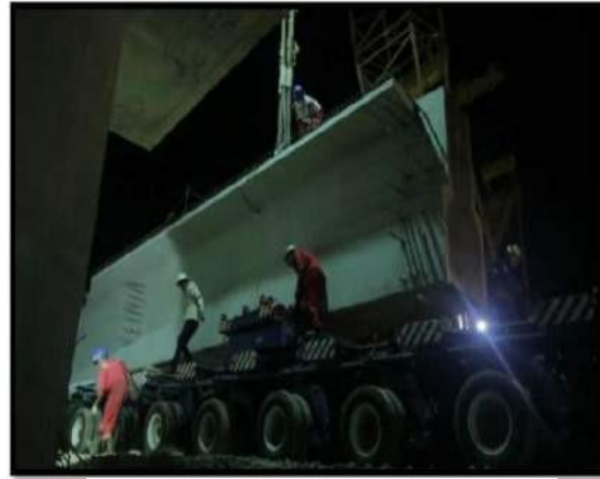
Gambar 7 Preloading Test sebelum erection
