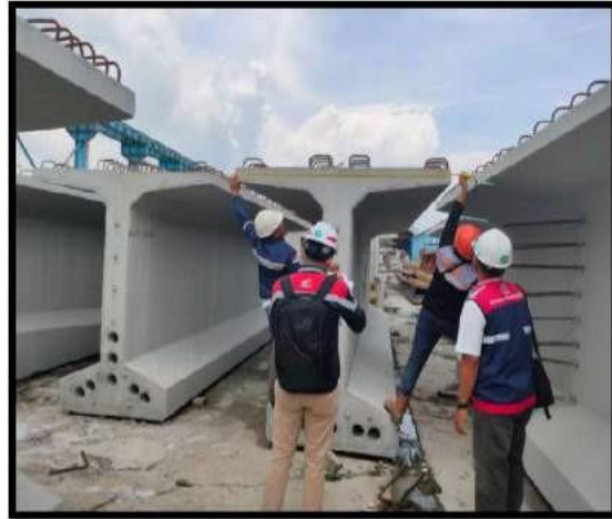
Gambar 13 Pengecekan Dimensi Girder sebelum pengiriman
