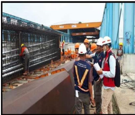
Gambar 12 Pengecekan Pembesian Sebelum Pengecoran
